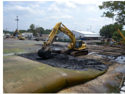
Dragado y recubrimiento de suelos contaminados
