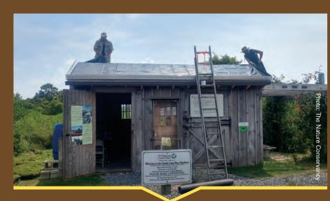
Usamos un sistema simple y modular de tejas de plástico recicladas con vegetación previamente incorporada, canales integrados para el flujo de aire y riego, y depósitos para la reserva de las aguas pluviales. Alineamos y apilamos las tejas de manera horizontal a lo largo del perímetro del techo hasta cubrirlo.
