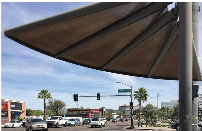
**Figura 5** Estructura de cortinas de acero perforado en las intersecciones brinda alivio a los peatones que esperan a que cambie la luz. Estas estructuras deben diseñarse y colocarse de manera que no interfieran con la visibilidad de las señales de tráfico.
