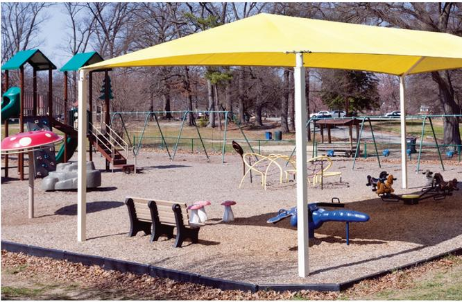
**Figura 1** Los dispositivos sencillos de sombra, apoyados en columnas en este caso, requieren mínima estructura. Los toldos se pueden quitar fácilmente en los meses más fríos, reemplazándolos cuando sea necesario por mantenimiento o cambiándolos por colores de temporada.
